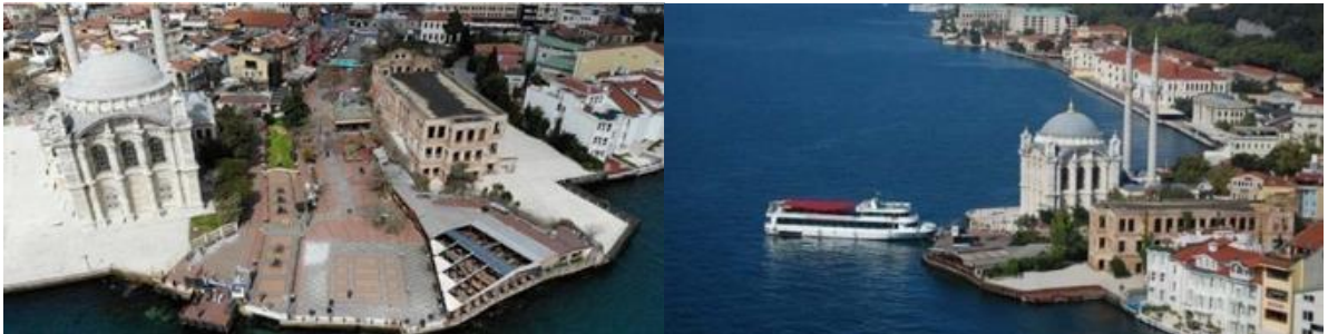
Şekil 21. Ortaköy Esma Sultan Yalısı Havadan Görünüm (Kayan,2020)
