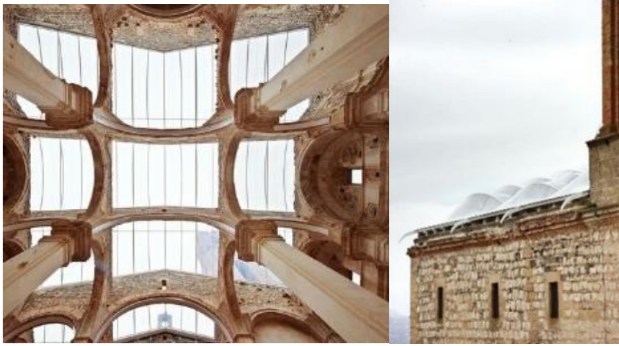
Şekil 14. Sant Pere Kilisesi Geçirgen Çatısı (Hevia,2013)
