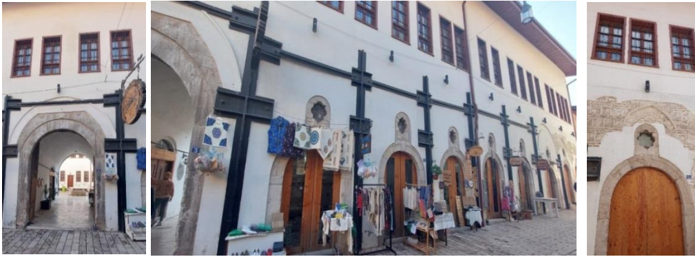
Şekil 12. Restorasyon Sonrası Yapının Giriş Kısmında Bulunan Taç Kapısı ve Kuzey Cephesindeki Dükkanlar (Güneş, 2023)
